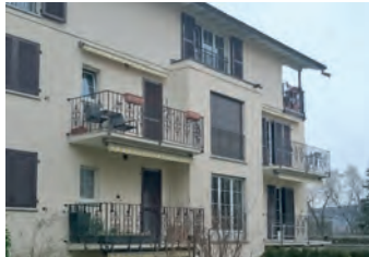
Honrainweg, Zürich ZH Baujahr 1953, Sanierung 2006 10 Wohnungen Bewertung: CHF 7'050'000.00
