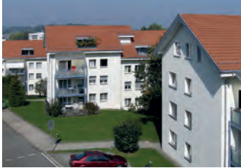
Berglistrasse, Wittenbach SG Baujahr 1962, Sanierung 1999 39 Wohnungen Bewertung: CHF 13'630'000.00
